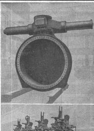
Oben: Drosselklappe 3200 mm Nennweite. Anlag in der Schweiz. Unten: Schnellschluss-Schleber 45 at Druck, Pump-
