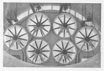
Abb. 2. Austrittseite mit sechs Gebläsen von 8,7 m ∅ für total 4650 m³/sec. Ansicht von innen. Man beachte die beiden Männer (unten) als Masstab.
