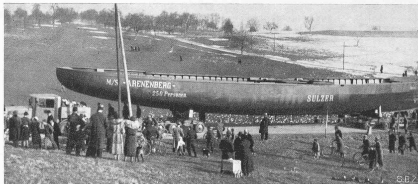
Schiffschale-Strassentransport Winterthur-Konstanz auf Rollschemeln. — Links Traktor; darüber das Heck der 34 m langen und 5,6 m breiten Schale von 24 t Gewicht.
