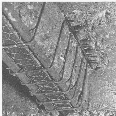
Abb. 4 bis 6. Durach-Eindeckung in Schaffhausen; Decken-Untersicht vor, während und nach der Instandstellung durch Gunit.
