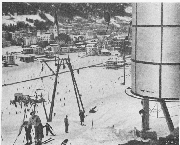
Abb. 5. Obere Umlenktrummel mit Tiefblick auf Davos und seine Skiläufer-Schleppseilanlage nach Patent Constam.
