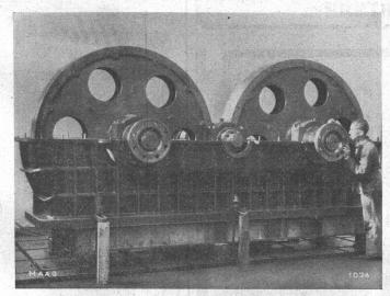
MAAG-GETRIEBE MIT GESCHLIFFENER SCHRAUBENVERZAHNUNG zwischen Dampfturbine und zwei Generatoren in Zuckerfabrik bei Paris (3900 PS bei 59 5/600 U/min.).
