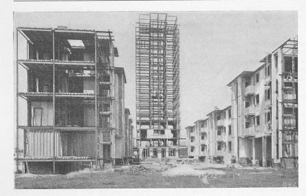
Abb. 8. Im Hof zwischen zwei Kammzähnen: verschiedene Montagezustände.
