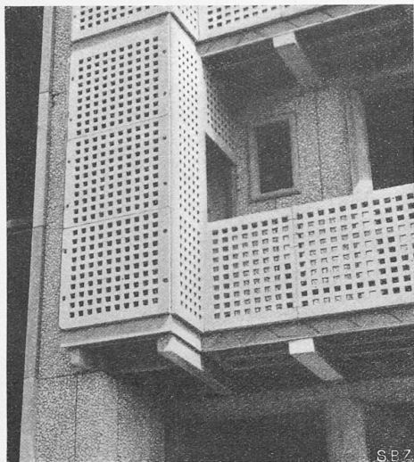
Abb. 5. Aussenwand- und Balkon-Elemente.
