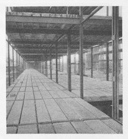
Abb. 4. Montiertes Stahlskelett mit aufgelegten Bodenelementen.
