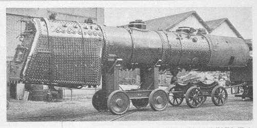
Abb. 3. Lokomotivkessel für 16 at Heissdampf, Rostfläche 4,86 m², feuerberührte Heizfläche 17,4 m², totale Heizfläche 308 m².
