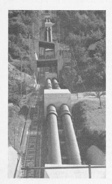
Die Druckleitungen für 175 at, ausgeführt durch Gebrüder Sulzer, Winterthur.
