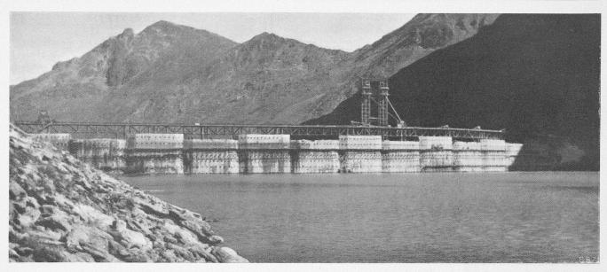
Das Wasserkraftwerk an der Dixence, Val d'Hérémence, Wallis. Bilder der Staumauer im Bauzustand vom September 1935. (Phot. K. Egli Zürich.)
