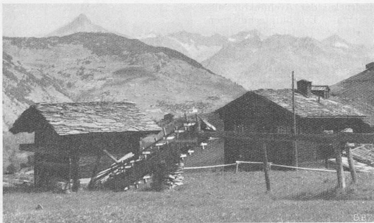
Alte Walliser Mühle mit hölzerner Druckleitung in Grächen (Vispental).
