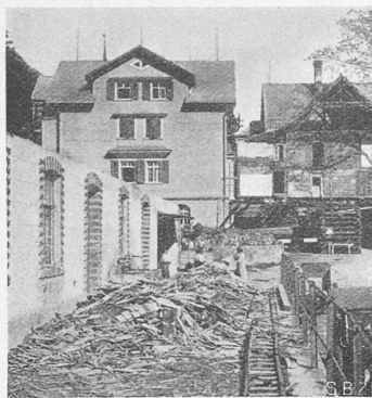
Abb. 2 und 3. Das Haus während der Längsverschiebung über der Strasse, von Westen gesehen.
