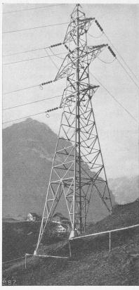
Abb. 57. Eckmast der 150 kV-Leitung Schwanden-Netstal bei Sool.
