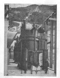
S.A. la Dixence, Kraftwerk Chandoline. — Drei Dreiphasen-Dreiwicklungs-Transformatoren 37'500 kVA, 13-65-135 kV, 50 Per p. sec. mit Stufenschaltern unter Last auf der Mittelspannung.
