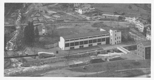
Abb. 44. Zentrale Schwanden: im Vordergrund der Sernf, links Einmündung des Niederenbaches und Druckleitung des Sernfwerkes.
