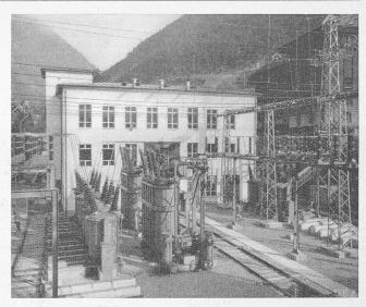
Abb. 46. Westfront des Dienstgebäudes und 150 kV-Freiluft-Schaltanlage Schwanden.
