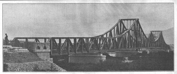
Strassenbrücke Diepoldsau. — Gesamtlänge 251,2 m; Stützweite der Mittelöffnung 92,5 m; Breite 7 m; Gewicht der Eisenkonstruktion ca. 870 Tonnen
