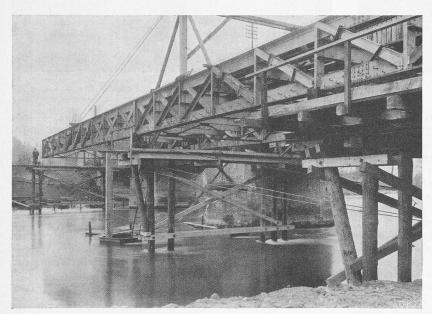
Eine Abstützung der Hauptträger im Flussbett während dem Betoniervorgang kam nicht in Frage. Zur Erhöhung der Haftfestigkeit wurden die Hauptträger genietet ausgeführt, ausserdem hat man auf die Hauptträgergurtungen und die Querträger aus INP 40 Armierungsdollen und Nietbolzen aufgeschweisst. Das Gesamtgewicht des Stahlskelettes dieser Brücke einschliesslich Auflager beträgt 83,4 t oder 130 kg/m², jenes der beiden Pendelpfeiler 68 t.
