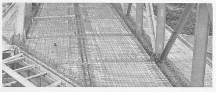
Abb. 1. Fahrbahn der Ilfisbrücke vor dem Betonieren. Alpha-Spiralen auf den Fahrbahnträgern.
