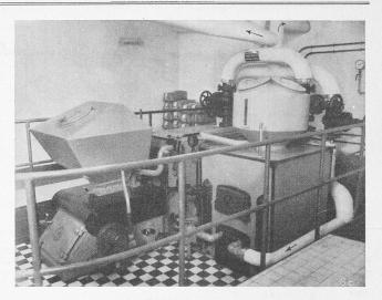
Abb. 1. Bild einer Luwa-Feuerungsanlage. Links Typ Mobil, rechts Typ Fix.
