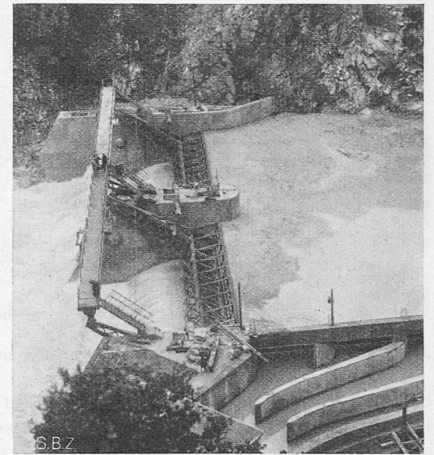
Abb. 10 und 11. Automatisches Wehr im Fiume Nete. Links Ueberlauf der Steuerorgane in Funktion.
