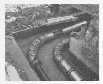
Abb. 6. Geöffneter Heizkanal bei der Durchführung der Isolierarbeiten.
