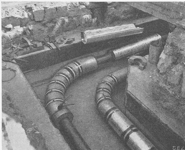
Abb. 6. Geöffneter Heizkanal bei der Durchführung der Isolierarbeiten.
