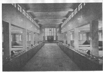
Hydraulisch gesteuerte Trinkwasser-Reinigungsanlage in offener Austührung "System WABAG-Breslau"
