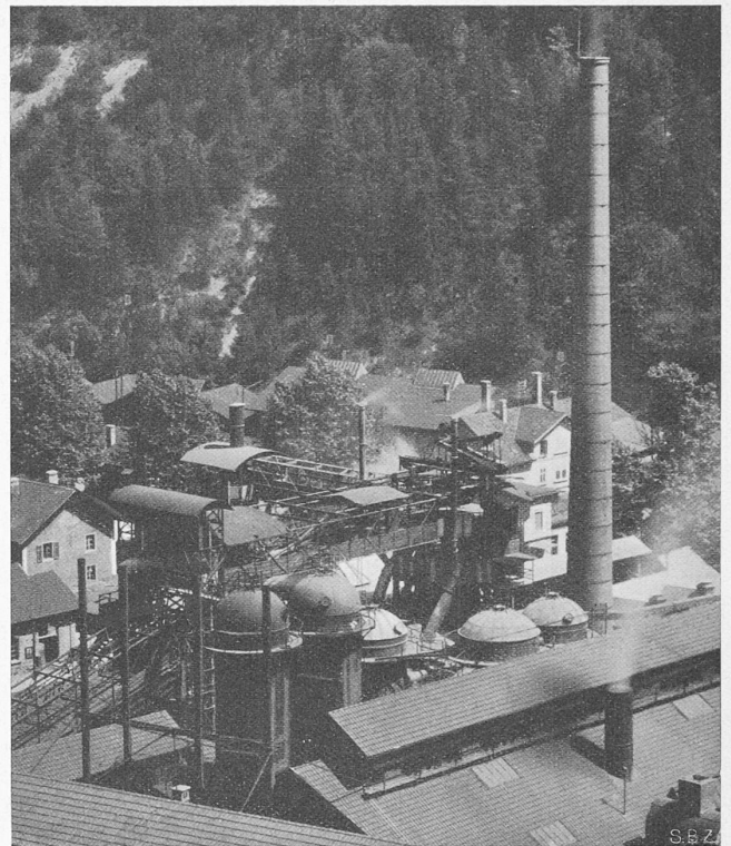
Abb. 3. Das Hüttenwerk Choindez der Gesellschaft der v. Roll'schen Eisenwerke im Frühjahr 1935. Der Hochofen steht links neben dem Hochkamin, darunter und links von ihm die Dome der Winderhitzer, über diesen die Beschickungsanlagen.
