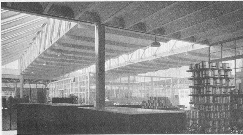
Abb. 15. Die hellen Arbeitsräume unter dem neuartigen Sheddach.
