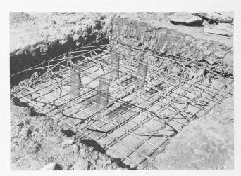
Abb. 12. Einzelfundament einer Stütze im Untergeschoss.
