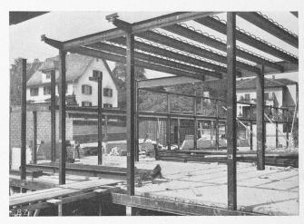
Abb. 13. Alphadecken der aufstockbaren Hallenlängsseiten.
