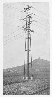
Abb. 8. Strebenloser Mast aus Rohren.
