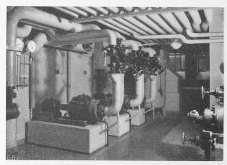
Abb. 34. Umwälzpumpen der Caliqua-Heisswasserheizung (im Sockelgeschoss).
