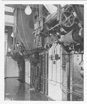
Abb. 35. Field-Heisswasserkessel, gebaut von Buss A.-G., Basel.
