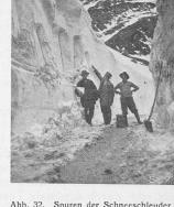
Abb. 32. Spuren der Schneeschleuder beim stufenweisen Abbau harten Lawinenschnees in der Val Tremola.
