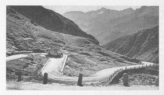
Abb. 30. Kehren A und B aus Abb. 29; Ri 4,5 m, Ra 9 m, Strassenbreite 7 bis 8 m
