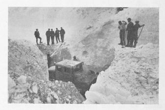
Abb. 31. Schneeschleuder System Peter in einer Tremola-Kehre. Lawinenschnee von 7 bis 11 m Höhe im Juni 1935.
