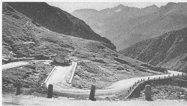
Abb. 30. Kehren A und B aus Abb. 29; R 1 4,5 m, R a 9 m, Strassenbreite 7 bis 8 m.
