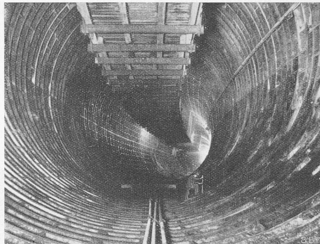
Abb. 12. Gusseisenpanzer des Merseytunnels. Der Arbeiter gibt einen Masstab für die Grösse des Tunneldurchmessers von 13,4 m.
