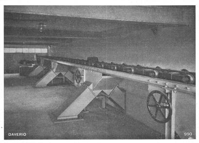
Oberer Becherstrang eines Kohlen-Conveyors mit Silo-Füllvorrichtung
