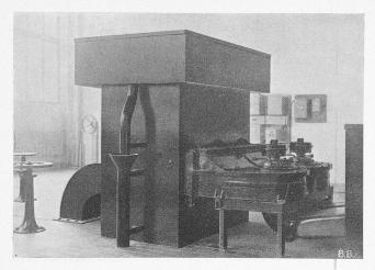
Abb. 10. Modellturbinen-Versuchstand mit Modellen 1:34 der Kaplanturbinen im Kraftwerk Dogern; links Oberwasser-, rechts Unterwasser-Behälter.
