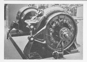
Abb. 6. Hochdruckkreiselpumpe, von der Pumpenseite aus.
