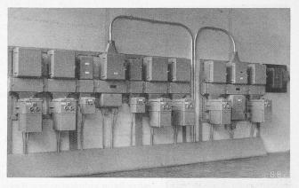
Abb. 13. Die zentrale Schaltanlage der hydraulischen Abteilung.
