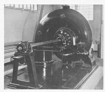
Abb. 14. Die Kavitationsturbine. Rechts am Bildrand das Unterwasser-Schwimmerpegel.
