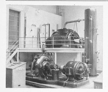
Abb. 2. Zwillingskreiselpumpe mit Schaltpult, im Hintergrund die Niederdruckturbine mit Messeinrichtungen und kleinem Windkessel.
