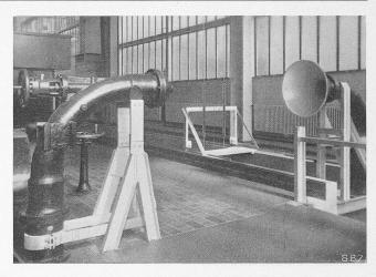
Abb. 11. Regulierbare Versuchs-Nadeldüse für Strahl bis 50 mm  $\oslash$  und 40 m/sec. Rechts Strahl-Auffangtrichter, im Hintergrund Stechpegel des Messkanals.
