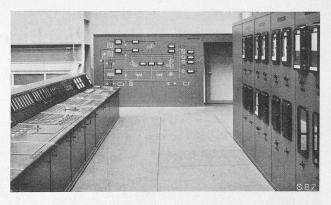
Abb. 7. Schaltwarte mit Leuchtschaltbildern, links Maschinenhalle.
