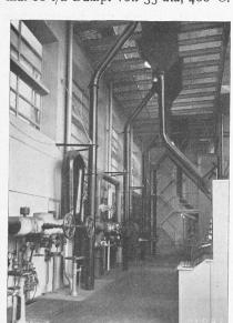
Abb. 16. Dampfdruck-Reduzierstation.
