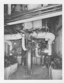
Abb. 24. Rohrkeller unter dem Speicher.
