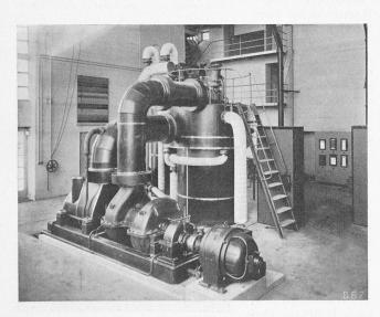
Abb. 18. Velox-Kessel Brown Boveri & Cie., von der Gebläseseite. Dampferzeugung 18 t/h, 35 ata, 400  $^{\circ}$  C; betriebsbereit in 5 bis 8 min.
