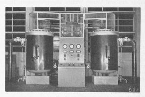
Abb. 19. Elektrodenkessel von Escher Wyss A.-G. mit der MFO. Dampferzeugung 2  $\times$  2,5 t/h, 11 ata, 180 °C Sattdampf.
