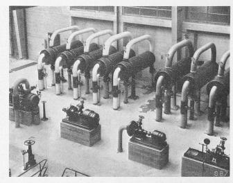
Abb. 21. Gegenstrom-Wärmeaustauschapparate für 11 und 2 ata des FHK.
