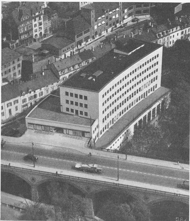
Abb. 1. Fliegerbild aus Süden. Vorn der Viadukt, links hinter dem Haus die unter dem Viadukt hindurch schräg verlaufende Birsigstrasse, rechts in der Tiefe der Birsig im Nachtigallenwäldchen.
