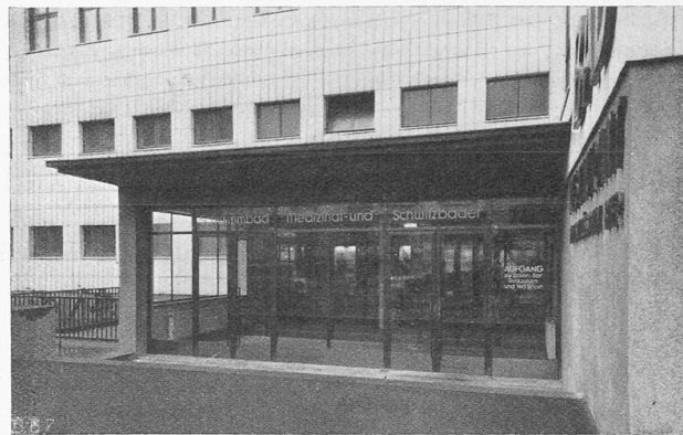
Abb. 4. Eingang zum Bad an der Birsigstrasse (Erdgeschoss).
