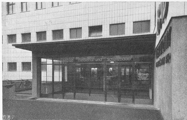
Abb. 4. Eingang zum Bad an der Birsigstrasse (Erdgeschoss).
