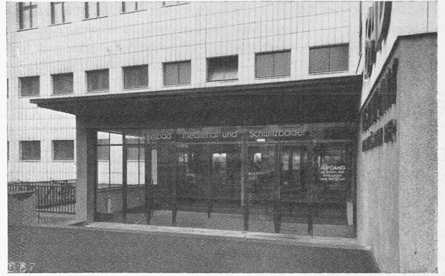
Abb. 4. Eingang zum Bad an der Birsigstrasse (Erdgeschoss).
