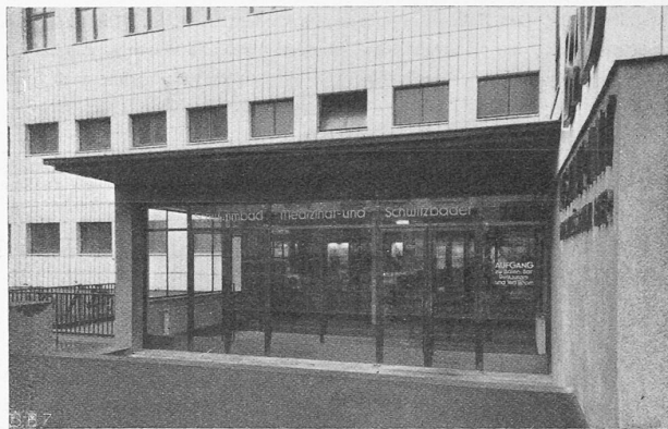
Abb. 4. Eingang zum Bad an der Birsigstrasse (Erdgeschoss).
