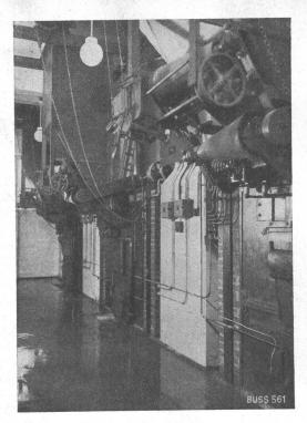
Drei Spezial-Heisswasserkessel mit mechanischer Beschickung, System Groll, 台 Patent, Fabrikat Buss A. G.
