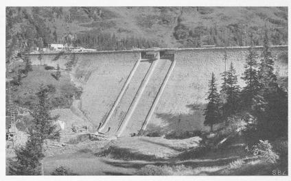
Abb. 26. Luftseite mit Hochwasser-Ueberläufen der 42 m hohen Hauptstaumauer Garichte.
