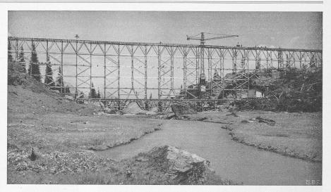
Abb. 31. Das Gerüst für den Bau der Hauptstaumauer Garichte, Blick talauswärts.
