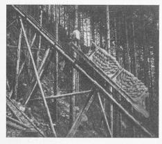
Abb. 23. Schrägaufzug längs der Druckleitung.
