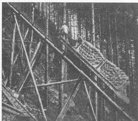
Abb. 23. Schrägaufzug längs der Druckleitung.
