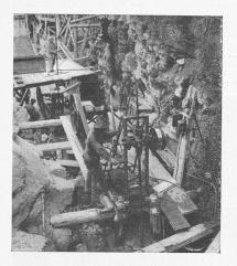
Abb. 32. Bohren von Injektionslöchern.
