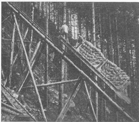
Abb. 23. Schrägaufzug längs der Druckleitung.
