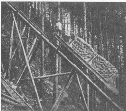
Abb. 23. Schrägaufzug längs der Druckleitung.
