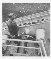
Abb. 10. Auflagerachse eines drehbaren Seilschuhes, Stütze 1.
