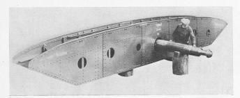
Abb. 9. Seil-Auflagerschuh mit Achse (für Stütze Nr. 1).
