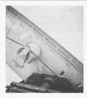
Abb. 12. Stützrolle des Hilfseiles am Auflagerschuh von Stütze 2.
