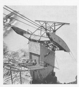
Abb. 8. Stütze 3 mit Haltestelle (Klapp-Perrons).
