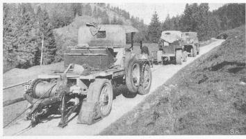
Abb. 16. Saurer-Traktor mit Winde für 15 t max. (kombinierte) Zugkraft.
