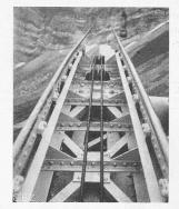
Abb. 11. Draufsicht eines Seilschuhes. Seil-Spurweite 660 mm; in der Mitte Zugseile.
