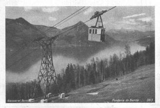
Antrieb, Streckenausrüstung und Laufwerke mit Gehänge erstellt durch die Giesserei Bern.
