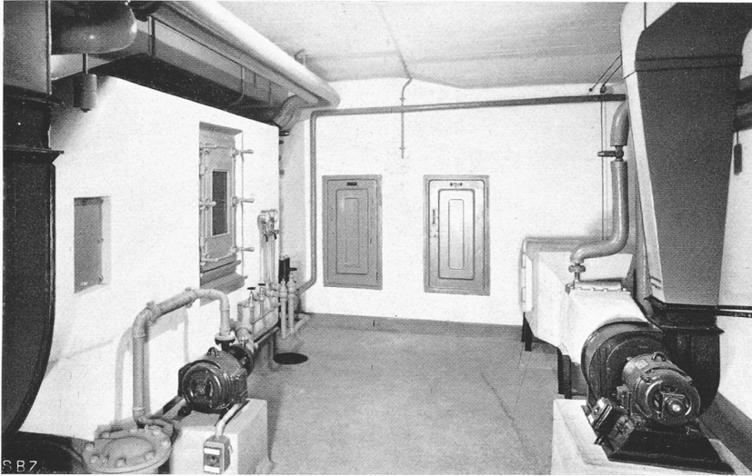
Abb. 22. Luftkonditionierungsanlage der Konsumbäckerei Winterthur.
