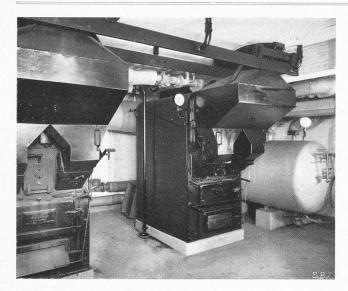
Abb. 17. Sulzer-Heisswasser-Taschenkessel.
