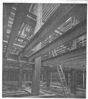
Tresorkonstruktion eines Bankgebäudes
