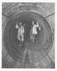
Abb. 15. Armierung der Gunitverkleidung im Sernfstollen bei WPV. (26. Februar 1931.)
