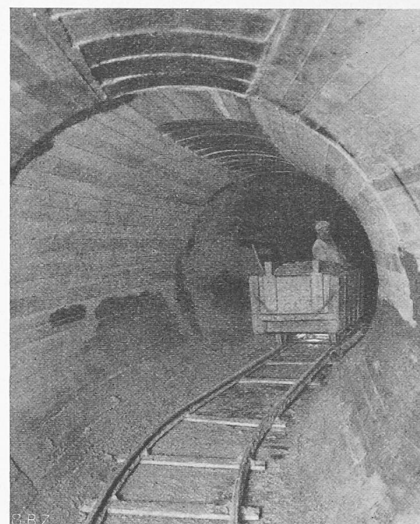
Abb. 16. Mit gehobelter und geölter Schalung betonierete Verkleidung bei WP III b.
