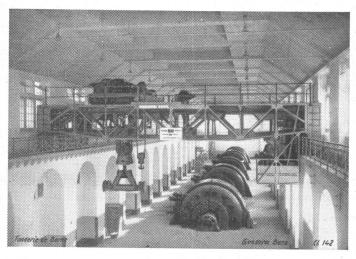
100 Tonnen Laufkran mit Lasttraverse in der Zentrale Amsteg der S. B. B.
