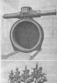
Oben: Drosselklappe 3200 mm Nennweite. Anlage in der Schweiz. Unten: Schnellschluss-Schieber 45 at Druck, Pumpspeicherwerk in Italien.
