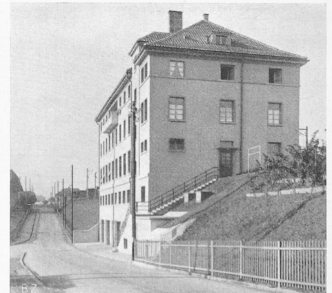
Abb. 10. Dienstgebäude (äussere Bahnstrasse).
