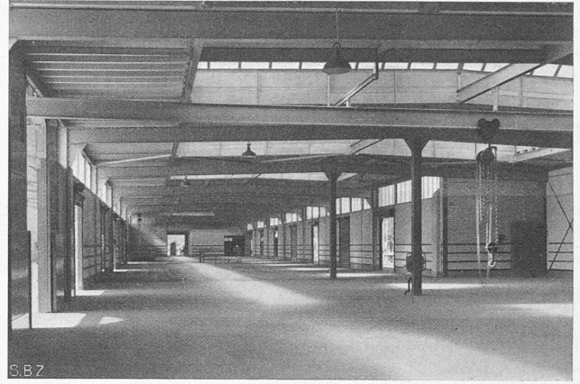
Abb. 7. Empfangshalle, links Strassenrampe, rechts Geleiseseite.
