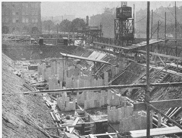
Abb. 16. Ausschnitt für die I. Etappe der Fundamentschwellen.
