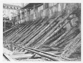
Abb. 17. Abspriessung der Stützmauer gegen die Walchestrasse.
