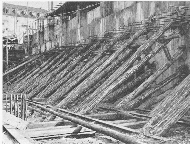
Abb. 17. Absperrung der Stützmauer gegen die Walchestrassse.
