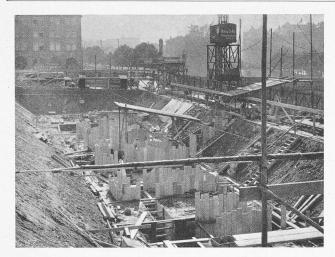
Abb. 16. Ausschachtung für die I. Etappe der Fundamentschwellen.
