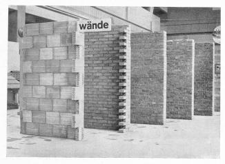
Abb. 1. Gemauerte Wände (Rückseiten verschiedenartig verkleidet).
