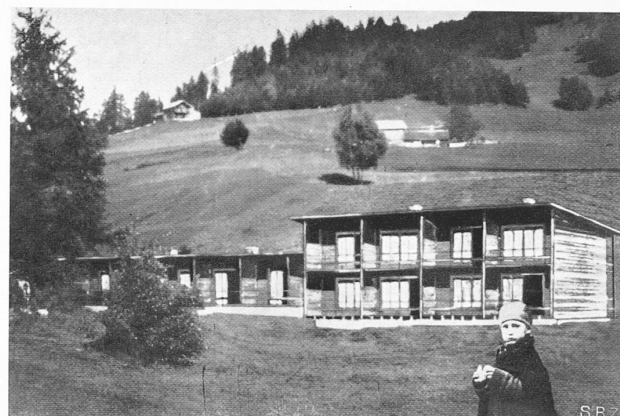
Abb. 39. Ferien-Appartement-Haus (2 × 4) + 6 Einheiten kombiniert. Entwurf Arch. Ernst F. Burckhardt, Zürich. Ausgeführt durch die Chäletfabrik Bündner Oberland, Ilanz, in Holzblockbau nach eigenem patent. System, innen ausgetäfelt.
