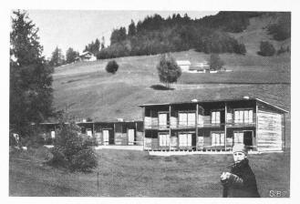
Abb. 39. Ferien-Appartement-Haus  $(2 \times 4) + 6$  Einheiten kombiniert. Entwurf Arch. Ernst F. Burckhardt, Zürich. Ausgeführt durch die Châletfabrik Bündner Oberland, Ilanz, in Holzblockbau nach eigenem patent. System, innen ausgetäfelt.
