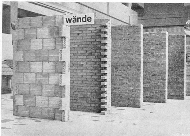
Abb. 1. Gemauerte Wände (Rückseiten verschiedenartig verkleidet).
