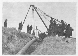
Einheben der fertig geschweissten 30,5 cm Ø Stahlrohrleitung
