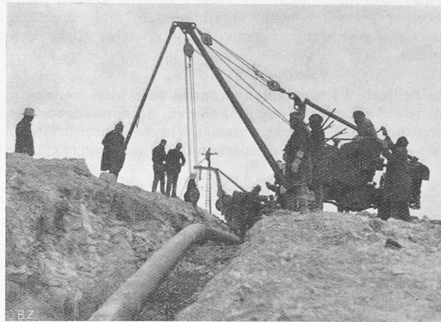
Abb. 5. Einheben der fertig geschweissten 30,5 cm Ø Stahlrohrleitung.
