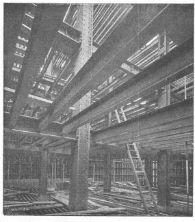
Tresorkonstruktion eines Bankgebäudes
