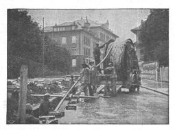
Verlegung von 6 kV Kabeln 3 × 240 mm² für das Elektrizitätswerk der Stadt Bern. Kabelgewicht ca. 100 000 kg.
