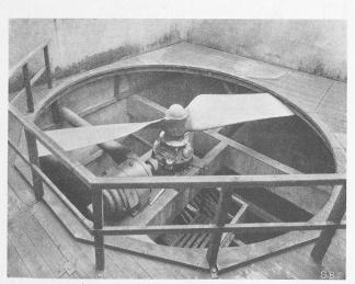
Abb. 1. Alter Ventilator von oben. Betonbalken, Motor und Getriebe unverkleidet. Starke Kontraktion der Luft am Umfang.
